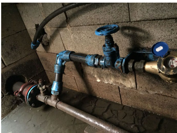
Wasserzählschacht Bewässerungsanlage
