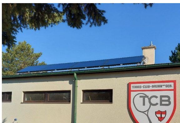
Neuerrichtung Solarpaneele am Dach
