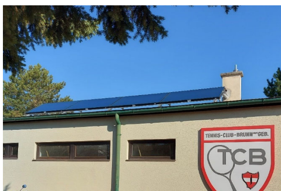
Neuerrichtung Solarpaneele am Dach
