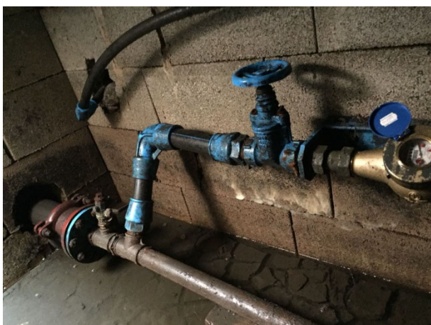
Wasserzählschacht Bewässerungsanlage
